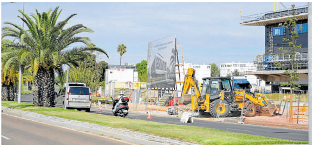
Imagen de las obras en la avenida de Elvas ayer por la mañana. J. V. ARNELAS
